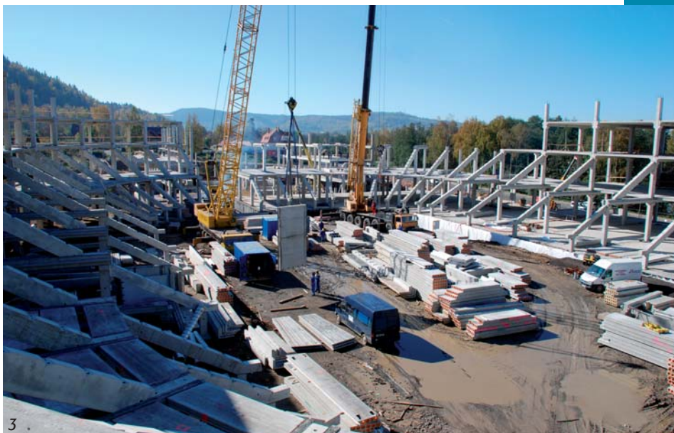
Obr. 3 Montáž prefabrikované konstrukce – celkový pohled
