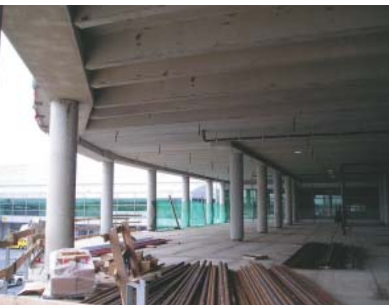
Obr. 20 Střešní konstrukce Fischerovy haly se zaobleným obvodem
