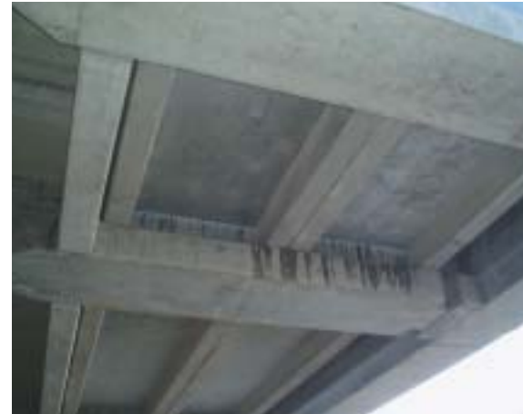
Obr. 11 Detail pohledu stropní konstrukce s travelátory
