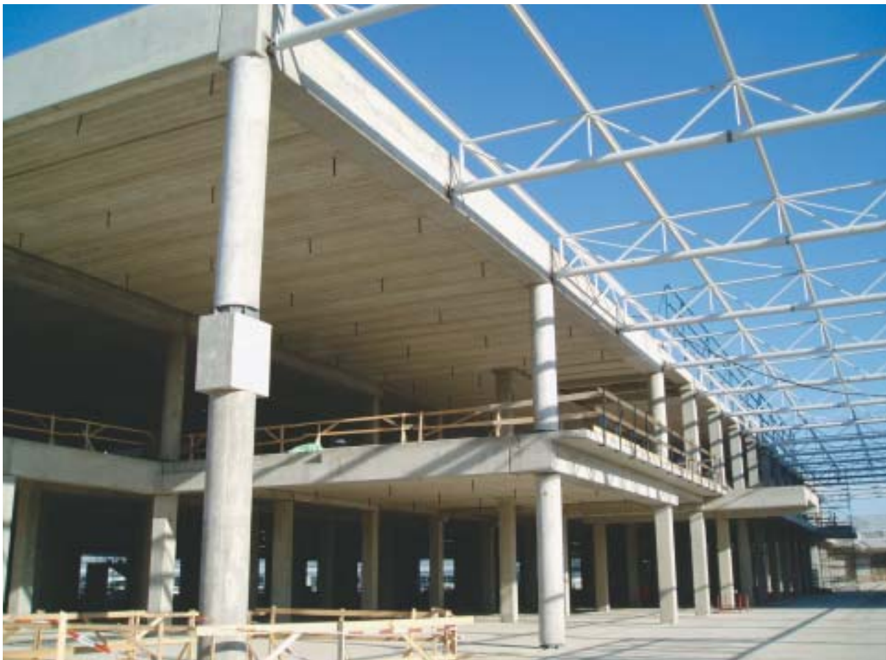
Obr. 7 Montované konstrukce s kruhovými a čtvercovými sloupy s vazbami na konstrukce ocelové
