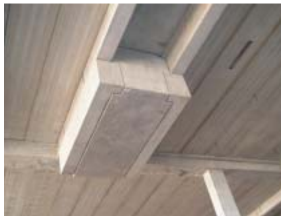
Obr. 12 Prefabrikovaný dojezd výtahu zabudovaný ve stropní konstrukci
