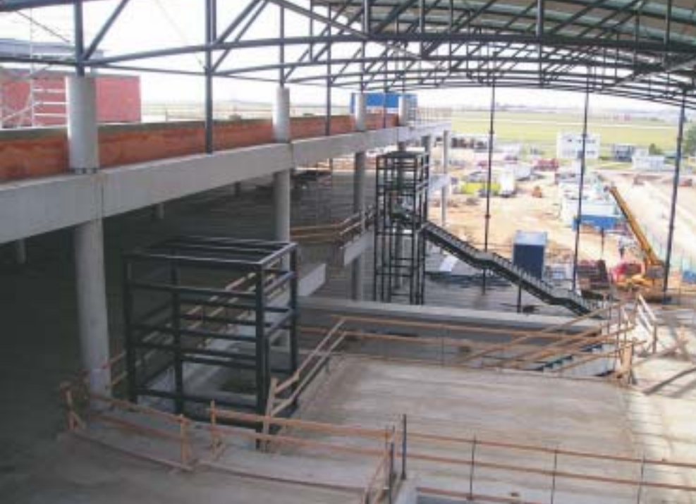
Obr. 17 Přiletová hala, kombinace prefabrikovaných a ocelových konstrukcí
