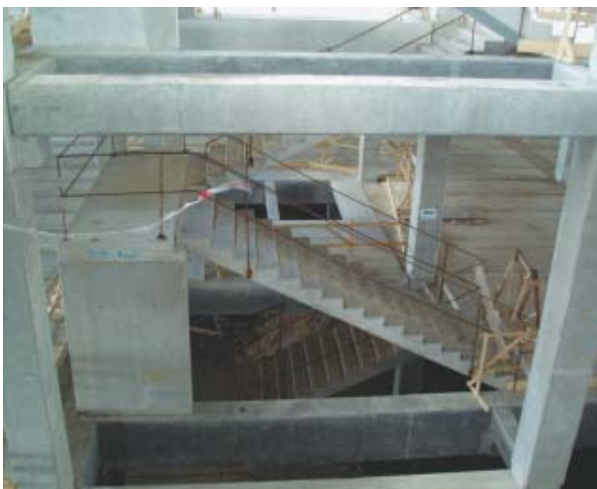
Obr. 16 Pohled na konstrukci jednoho z mnoha komunikačních jader
