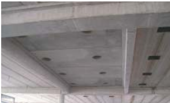
Obr. 6 Různé druhy otvorů ve stropní konstrukci
