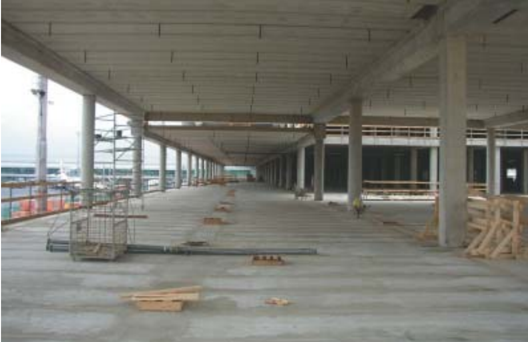
Obr. 3 Stropní konstrukce s modulem 12/12 m
