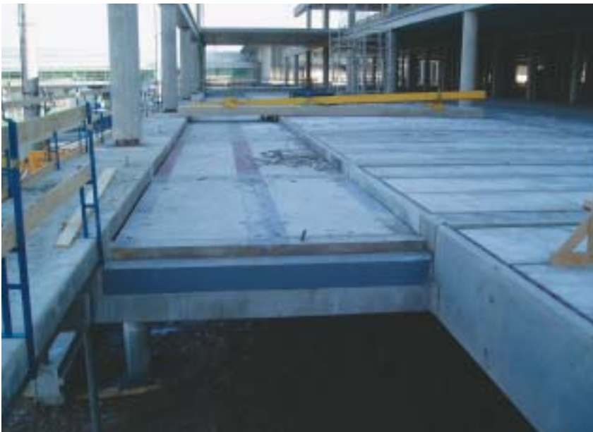
Obr. 10 Pohled na strop s vybráním pro travelátory
