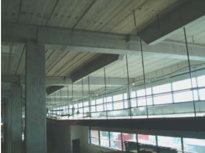
Obr. 14 Chodbový trakt, zavěšený do stropní prefabrikované konstrukce
