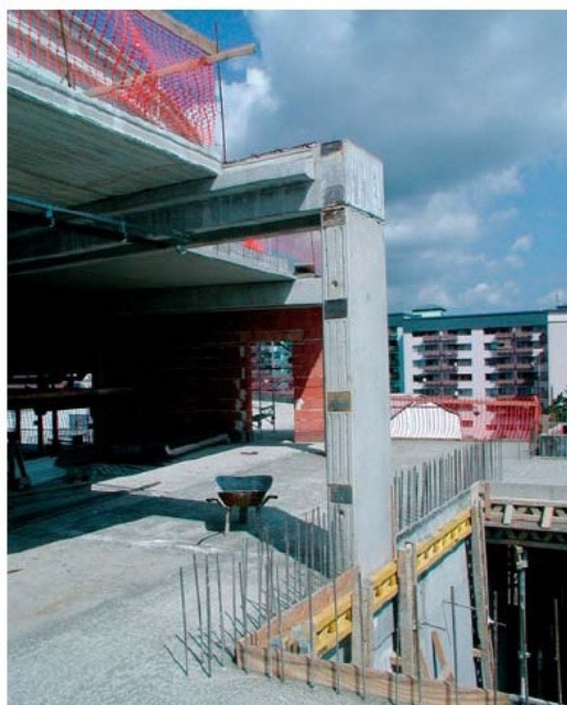
Fig. 9 Prefabricated wall unit – an earlier assembler support of a crossbeam. It is a part of the monolithic core Obr. 9 Prefabrikovaný stěnový dílec – v předstihu montovaná podpora rámové příčle. Je součástí monolitického komunikačního jádra
