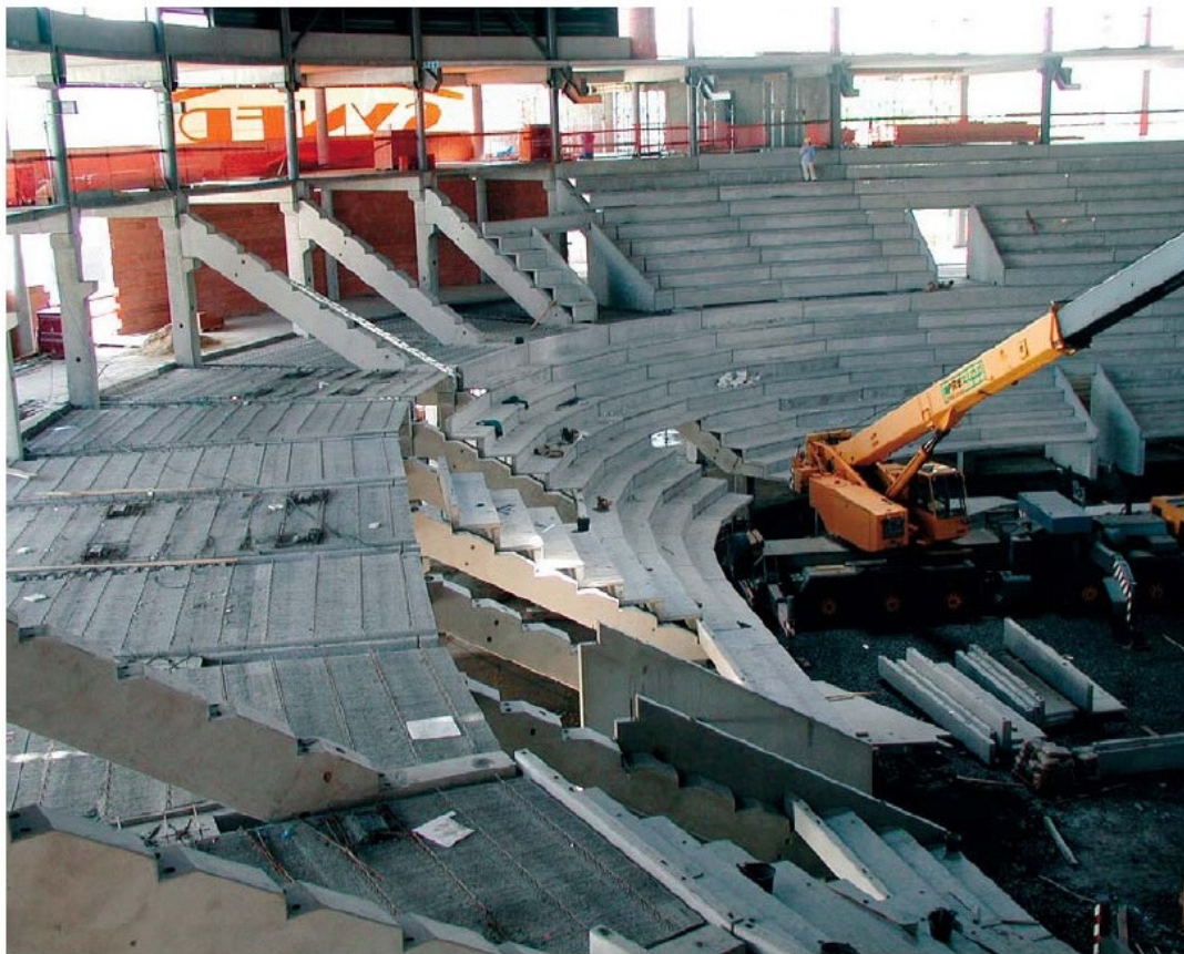
Fig. 10 Assembly of a prefabricated stand from the internal already roofed stadium area Obr. 10 Montáž prefabrikované tribuny z vnitřní již zastřešené plochy stadionu
