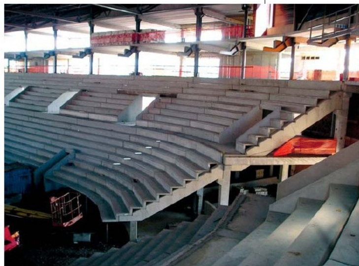
Fig. 5 View on a part of an uncovered frame with stand beam, twin beam and benches Obr. 5 Pohled na část obnaženého rámu s tribunovým nosníkem, zdvojeným nosníkem a lavicemi
