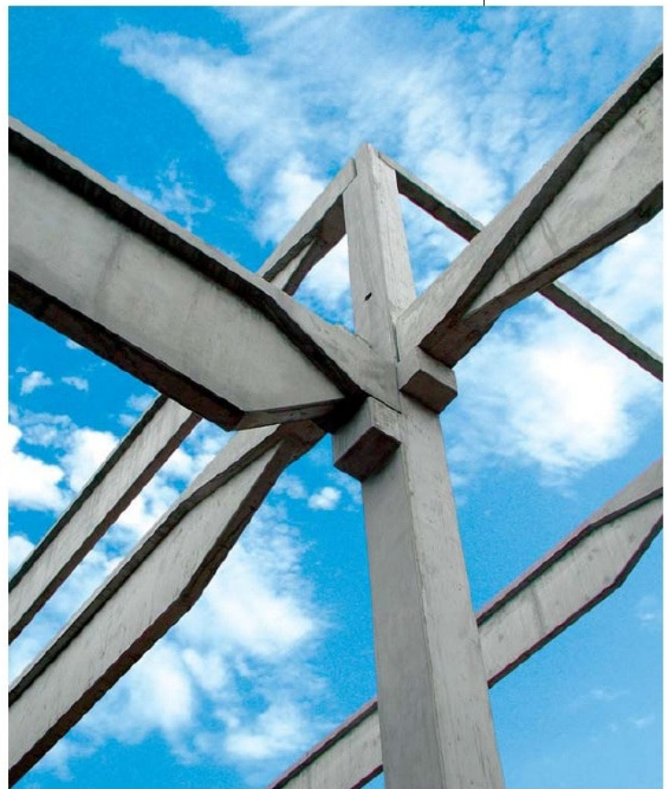
Fig. 5 Column with change of the roof height Obr. 5 Detail umístění v místě změny výšky haly
