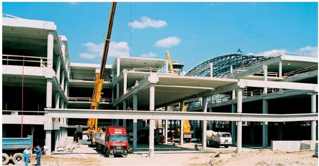
Fig. 2 General view of the process of the skeleton assembly Obr. 2 Celkový pohled z průběhu montáže skeletu
