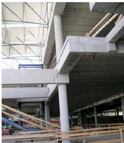
Fig. 11 View of a 44 t beam with overhanging cantilevers Obr. 11 Pohled na 44 t nosník s převislými konzolami
